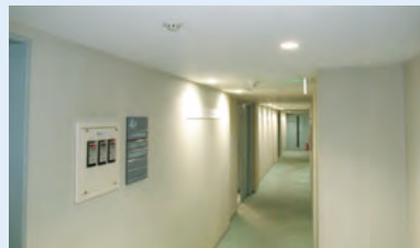
事務所、共用部のLED化完了(本社)
