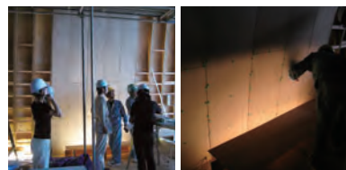
照明器具の取り付け位置の打ち合わせ
