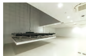
天井昇降装置
