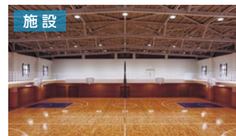
施設 学校法人関西学院高等部体育館(兵庫県)
