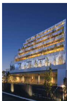
コイズミ照明R&Dセンター(南側外観)
